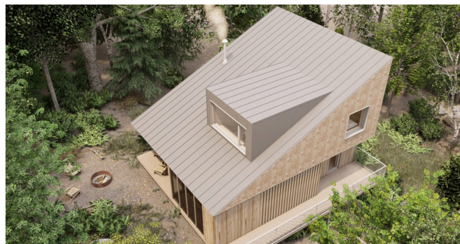
La construction se fait en minimisant l'impact sur le territoire. Crédit photo : Gracieuseté BESIDE Habitat
