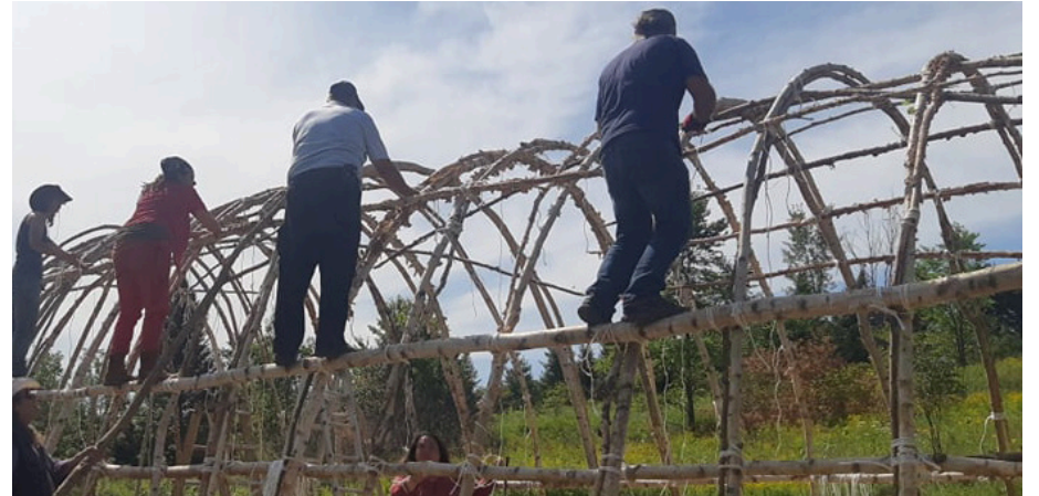
Photo prise lors de la construction d'un wigwam de style maison longue, avec le métis François Désilet et la Communauté Autochtone Petite-Nation. Sur la photo : Gino 'IO' Salotti tenant une perche, en bas.
