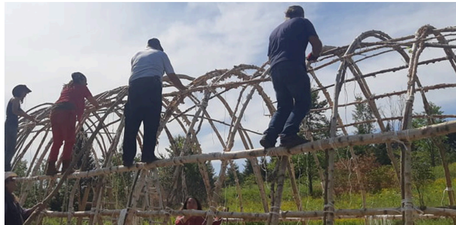
Photo prise lors de la construction d'un wigwam de style maison longue, avec le métis François Désilet et la Communauté Autochtone Petite-Nation. Sur la photo : Gino 'IO' Salotti tenant une perche, en bas.
